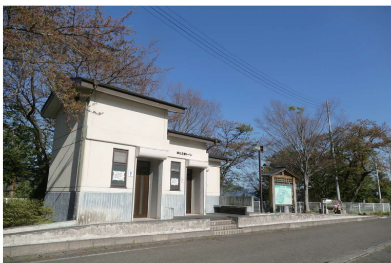
生涯学習課が地域整備課に解錠を要請した城山公園の公衆トイレ
