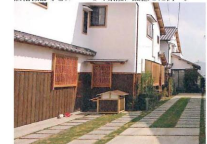
設備機器等をカバーして景観に配慮した例 *1
