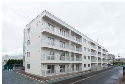
公営住宅の例（備後第一アパート）
