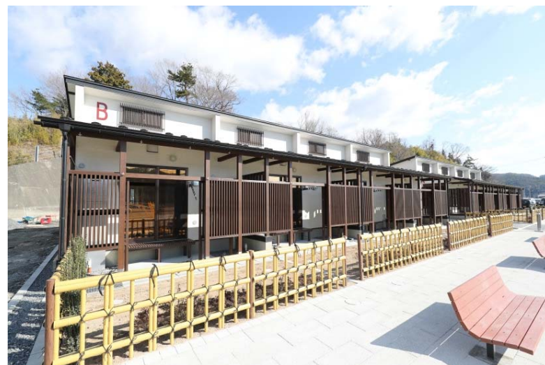
本町1・上町災害公営住宅 H29.3 完成
