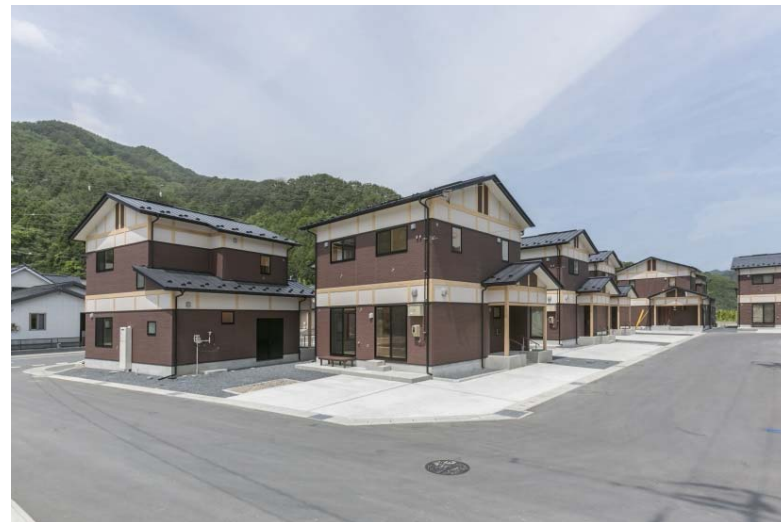
寺野第2災害公営住宅 H28.7 完成
