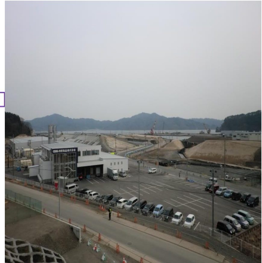
H29.3 安渡産業集積地 工事状況
