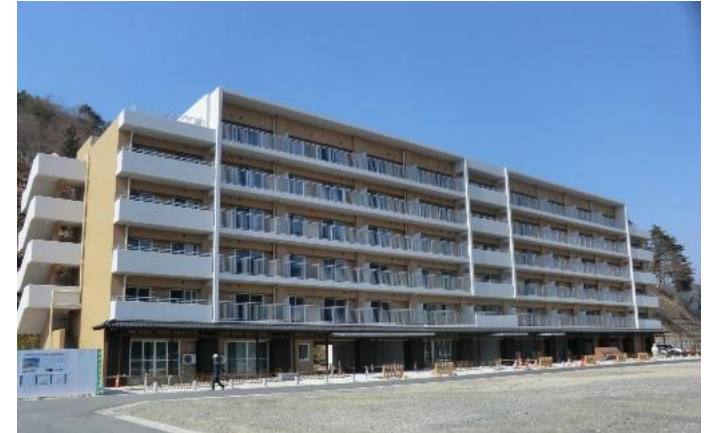
末広町災害公営住宅 H28.03完成
