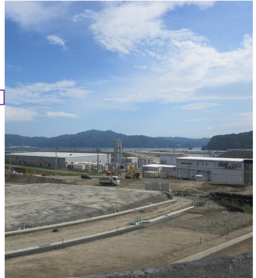
H28.8 安渡産業集積地 工事状況
