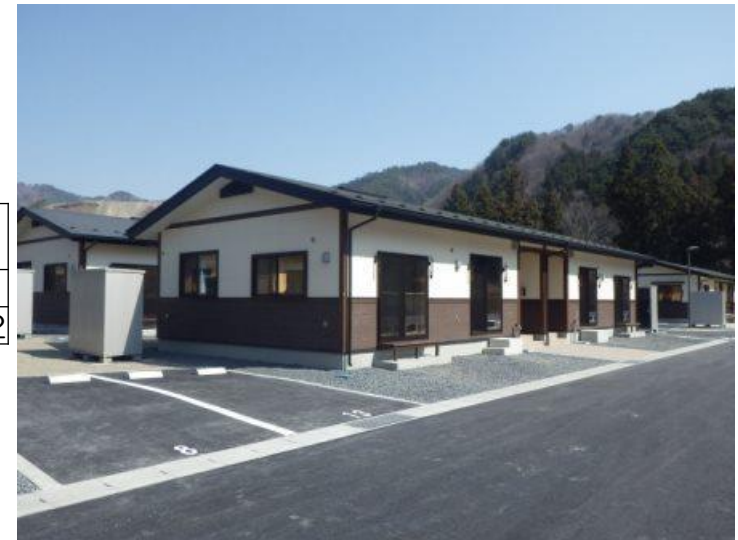
柵内第2災害公営住宅 H28.03完成
