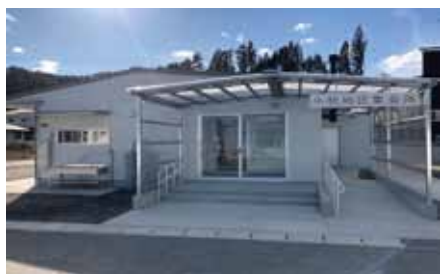
完成した小枕地区集会所
