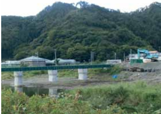
復旧中の小鉾川鉄橋
