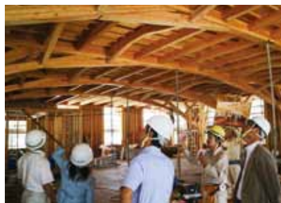
柱のない大空間が広がる3階図書館
