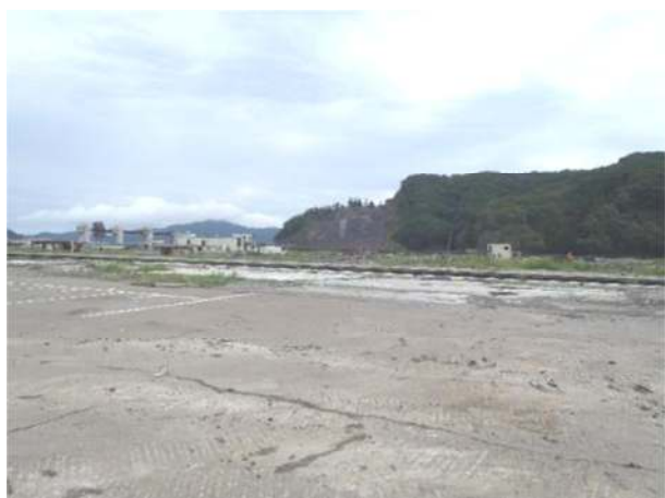
写真 2-1 被災した JR 山田線（平成 23 年 8 月）
