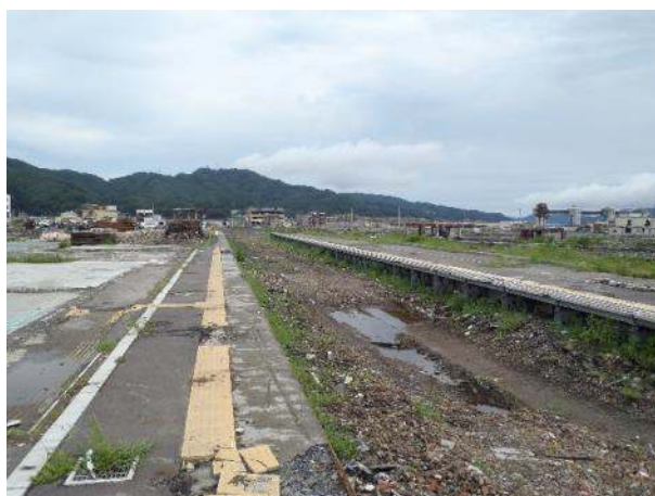
写真 2-2 震災後の大槌駅跡（平成 23 年 8 月）
