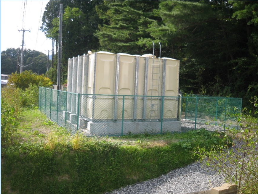
写1 (仮)配水ポンプ場
