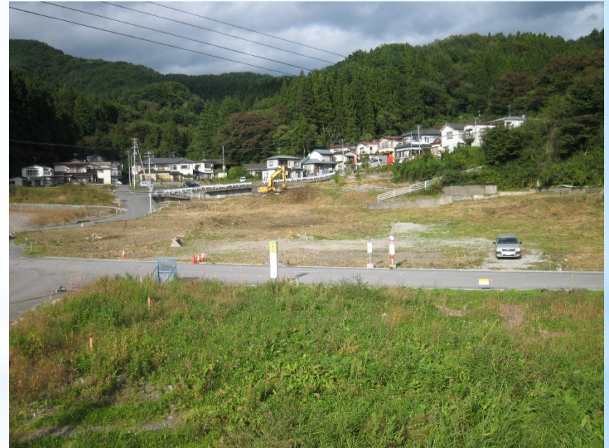
写4 支障物撤去
