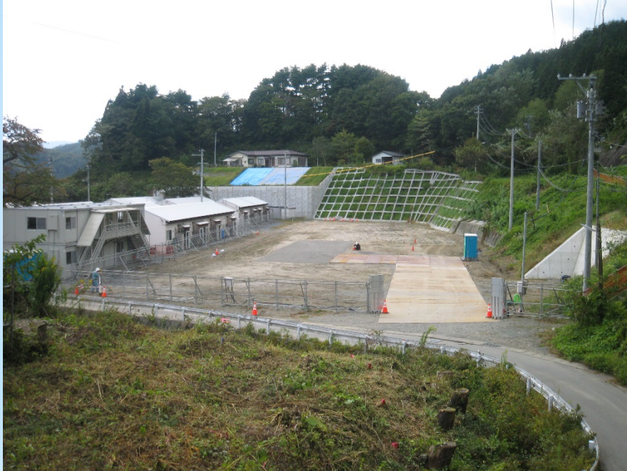
写5 法面工事(完了後)
