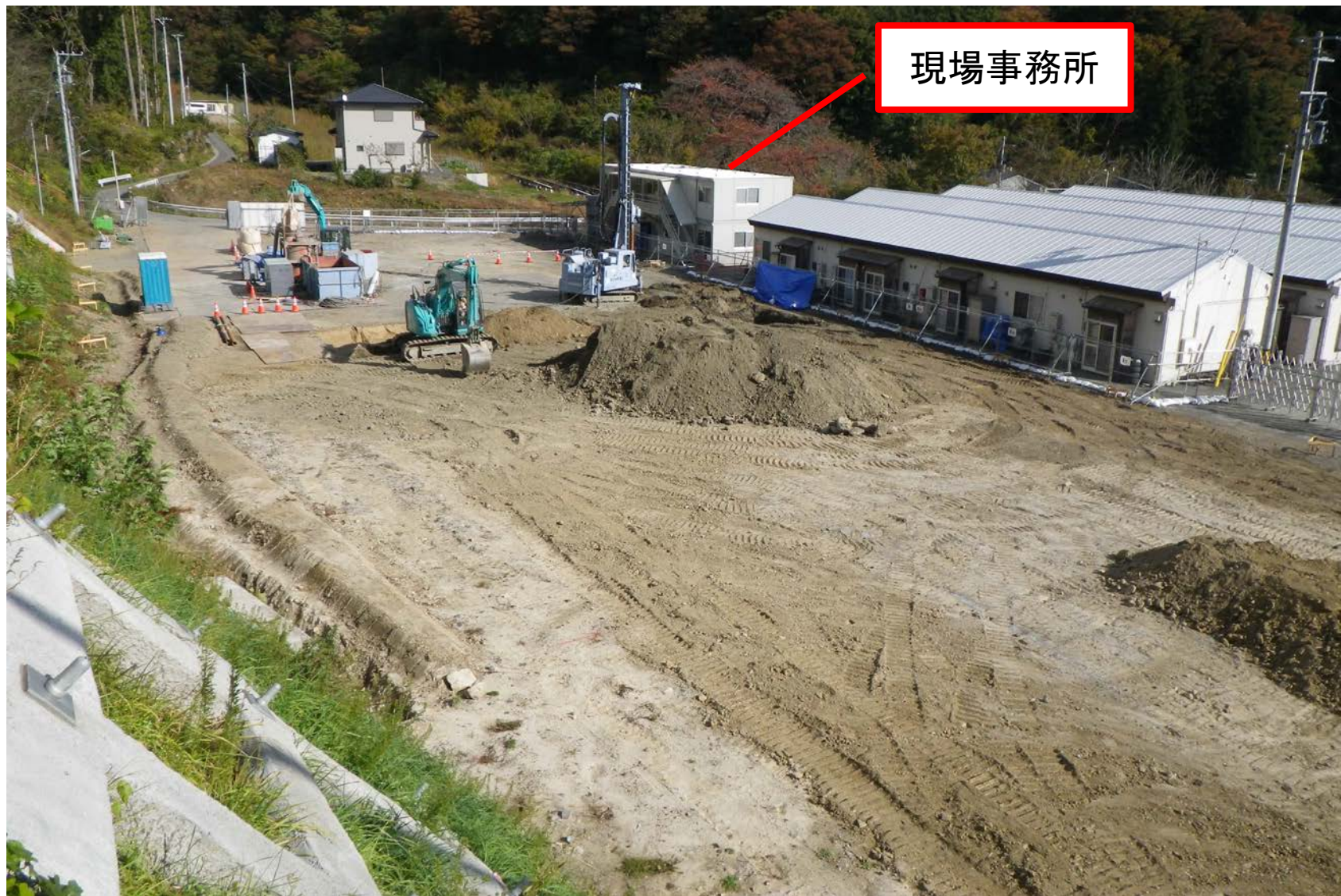
公民館・避難ホール建設現場（旧安渡小跡地） 西側斜面から撮影（27年10月末現在）
