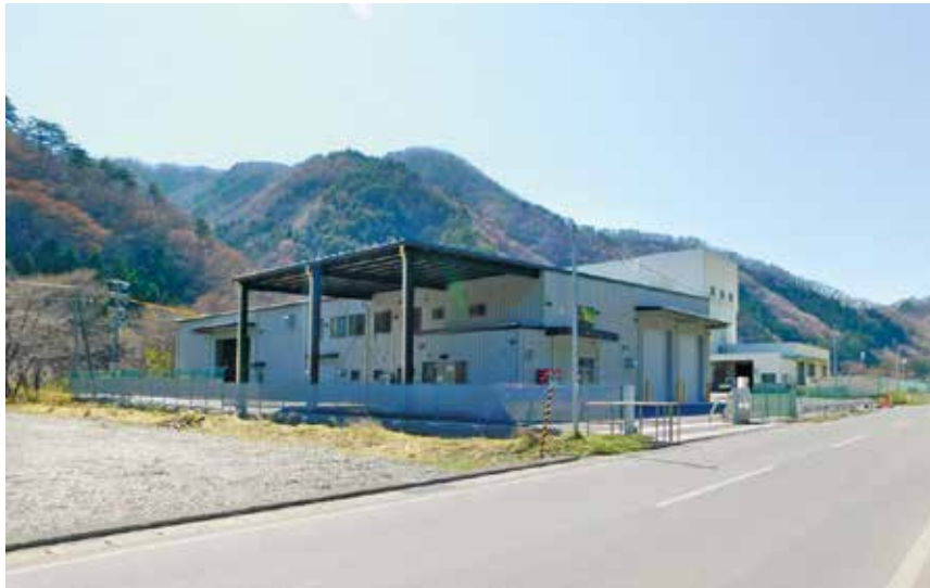
4月3日に竣工式が行われた「大槌町リサイクルセンター」
