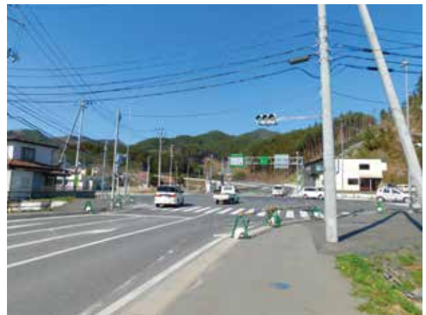
三陸自動車道の大槌インターチェンジ
