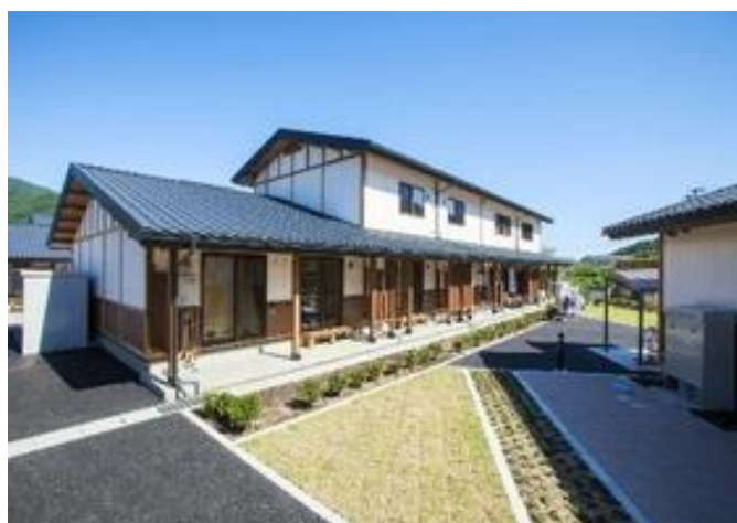
地場産材の活用と壁面デザイン (大ケロ災害公営住宅)
