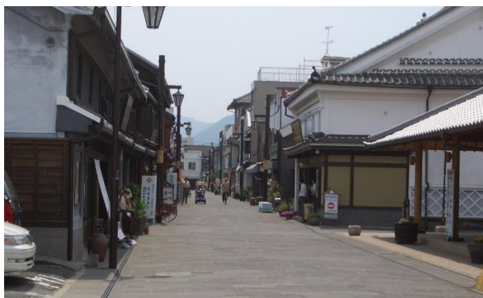
ブロック舗装（大分県臼杵市）
