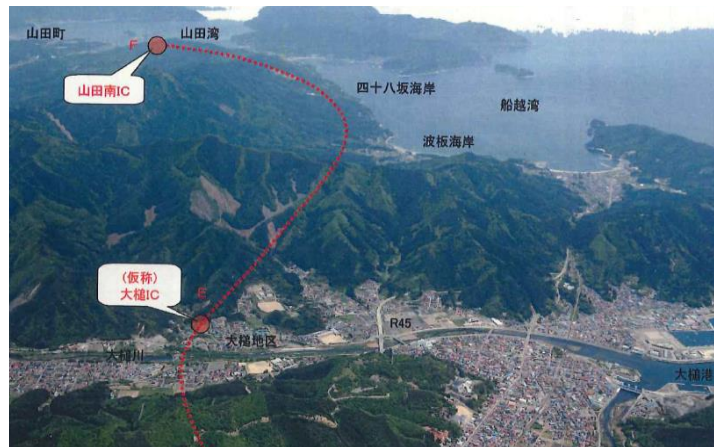
景観整備に取り組む三陸沿岸道路【大槌(仮称)～山田】
