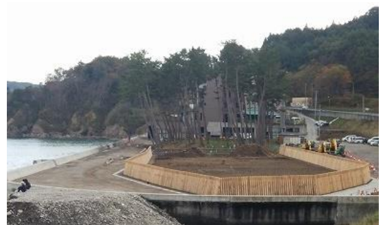
松の苗を植えるための風よけを設置して松原の再生に取り組む（浪板海岸）
