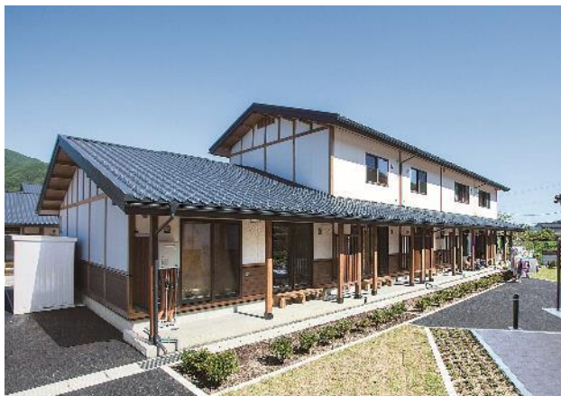
第8回の地域住宅計画賞（地域住宅計画推進協議会主催）を受賞した大ケロ災害公営住宅（大槌町）
