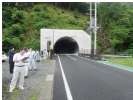
新大槌トンネル（大ヶロー三枚堂） 安全への工夫や対策を講じているが工事車両の通行は依然として多い。
