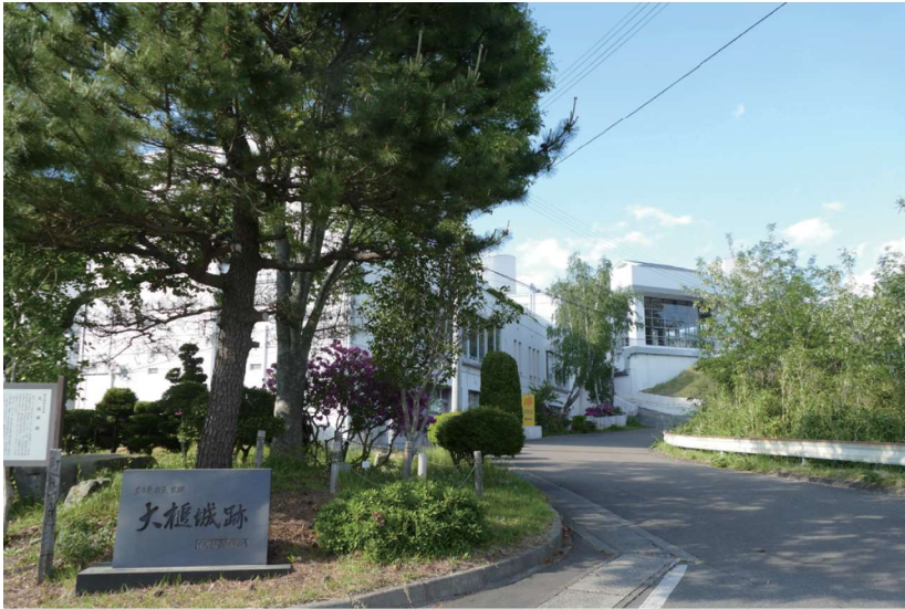
震災当時の地域防災計画で庁舎被災時に仮設災対本部が置かれることになっていた中央公民館
