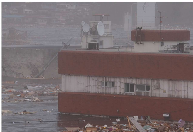
津波にさらされる役場庁舎（奥の建物）。屋上の塔屋に職員が逃げ込んでいるのが見える＝2011年3月11日午後3時25分、植田俊郎さん撮影
