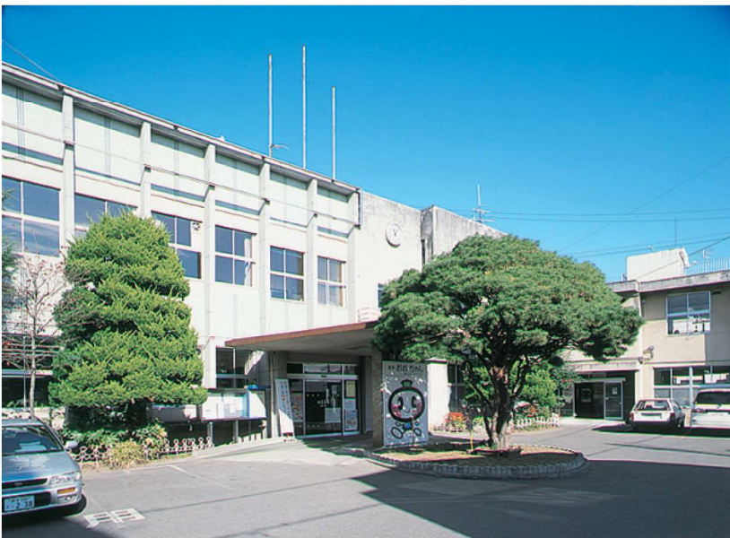
震災前の役場庁舎。中央棟は震災当時で築57年が経過していた
