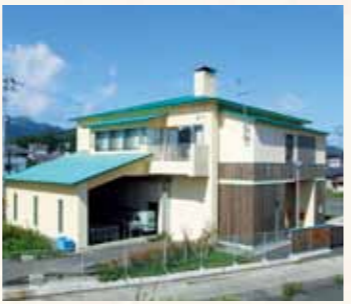
大町雨水ポンプ場
