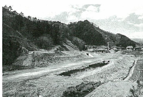
花輪田寺野線道路改良事業は、平成十四年度の供用開始に向け事業を進めています
