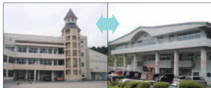
吉里吉里学園：施設分離型小中一貫教育校 既存の校舎を活用し、これまでのコミュニティの良さを維持し豊かにしていく地域
