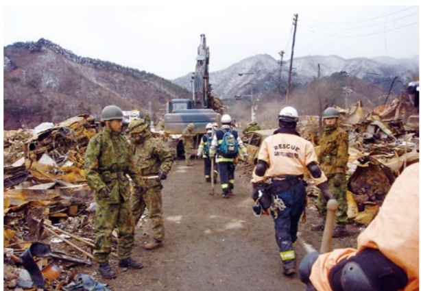
自衛隊による道路啓開作業
