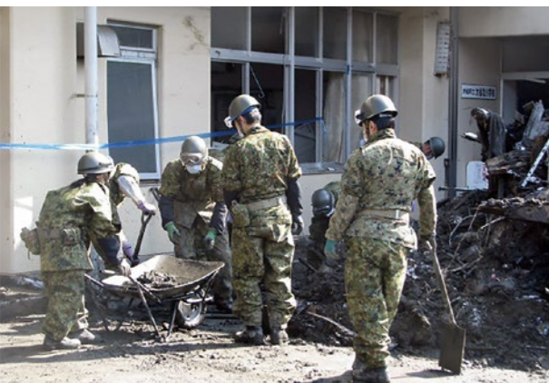
解体前の建物の周辺や屋内のがれきを処理する自衛隊
