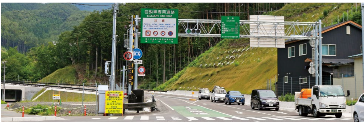
沢山地区に整備された大槌インターチェンジ
