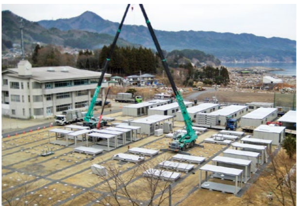
吉里吉里中学校のグラウンドに建設されるプレハブの仮設住宅
