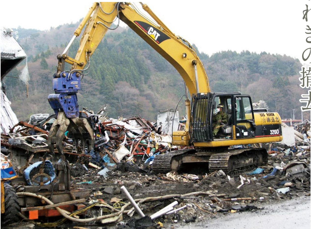
がれき撤去のために重機が大量に必要となった(2011年4月27日撮影)
