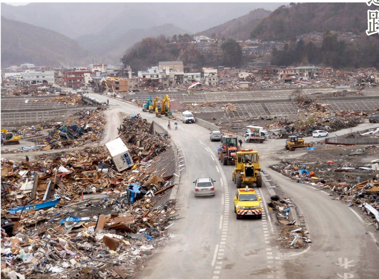
がれきを取り除いて通行可能になった、安渡一丁目付近の県道大槌小槌線
