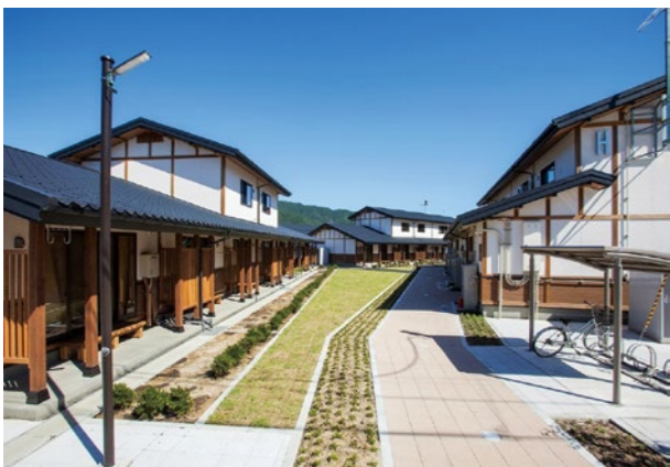
地元産の木材を使った温かみのあるデザインの大ケ口災害公営住宅
