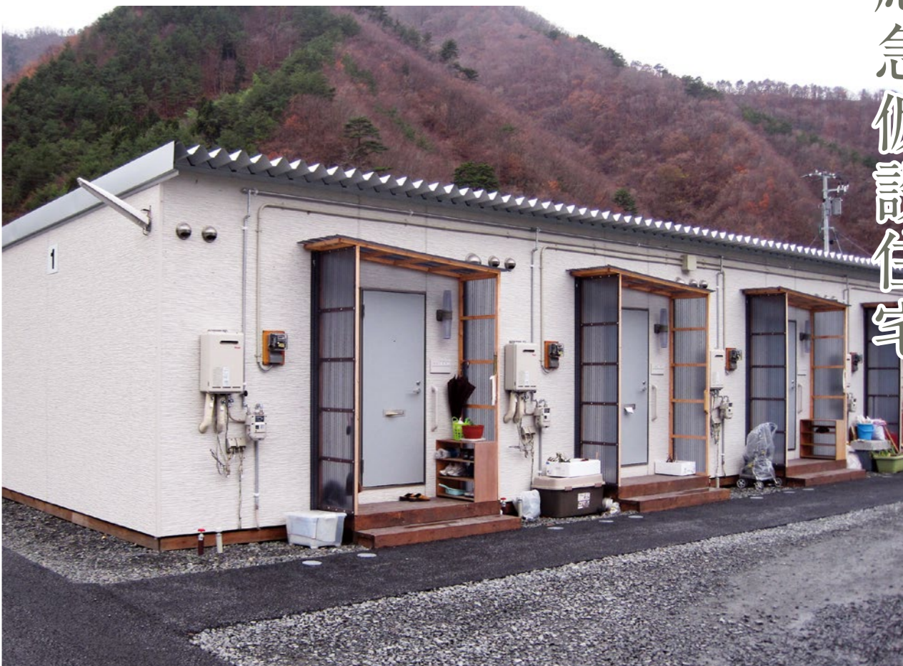
浸水区域外の小鎗地区には、町内で最も多い849戸の仮設住宅が建設された
