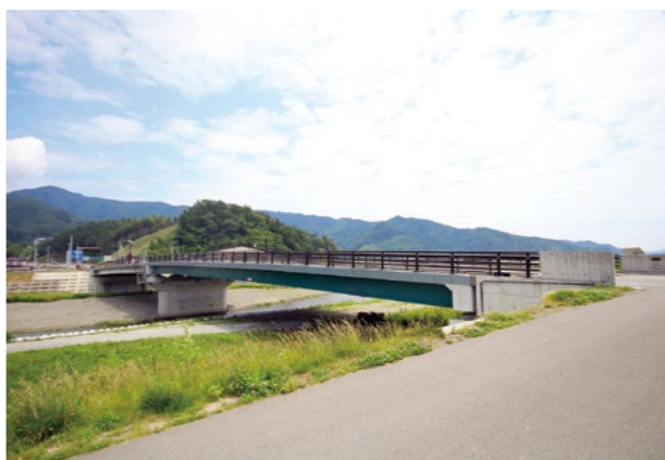
大槌インターチェンジ付近に設けられた源水大橋
