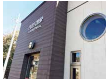
ホームに新設された吉里吉里駅
