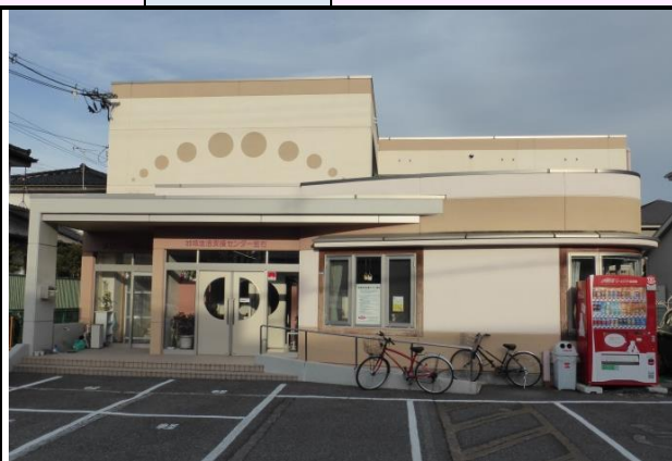
建物の2階部分がグループホームです
