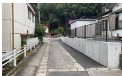
一部拡幅を行った高森団地線
