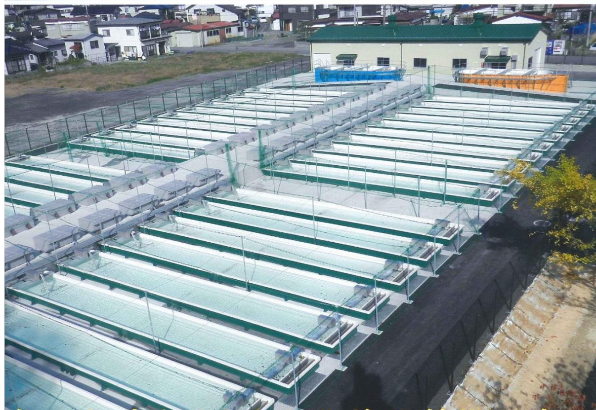
【さけ・ます ふ化施設】
