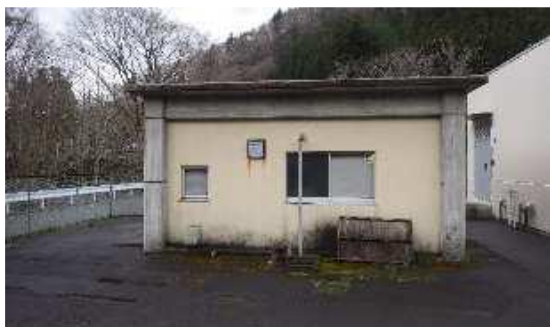
昭和 55 年築 小鎚浄水場発電機室 (RC 造 面積=30.0 m 2 )
