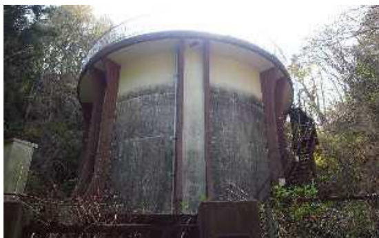
昭和 57 年築 吉里吉里第 1 配水池 (PC 造 容積603 m 3 )
