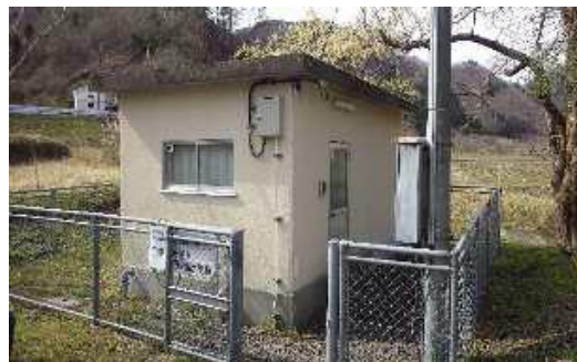
昭和 59 年築 白銀浄水棟 (RC 造 面積=13.1 m 2 )
