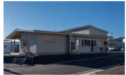
昨年竣工した新工場
