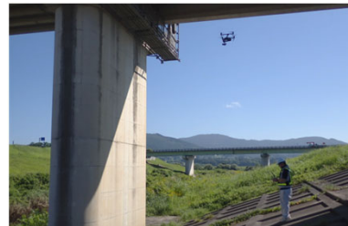
写真3 左:画像解析ソフトを用いて作成した点検調査 右:ドローンによる撮影
