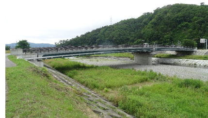
写真1 源水大橋(鋼橋・橋長91.2m)
