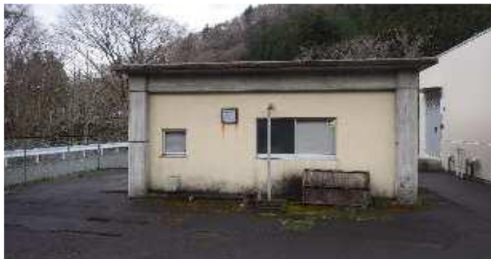
昭和55年築 小鎚浄水場発電機室 (RC造 面積=30.0 \text{m}^2 )
