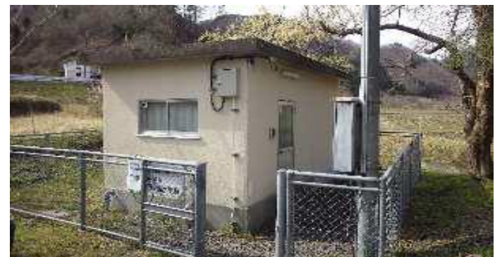
昭和59年築 白銀浄水棟 (RC造 面積=13.1 \text{m}^2 )
