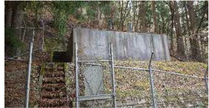
昭和49年築 金沢配水池 (RC造 容積=81.2 \text{m}^3 )
