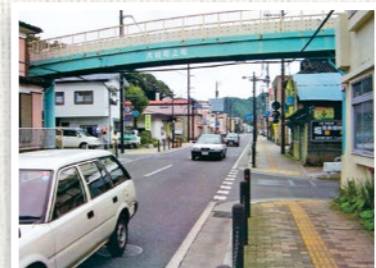
町方地区(上町) / 旧大槌小学校前歩道橋
