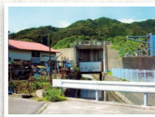
安渡地区 / 漁港付近水門
