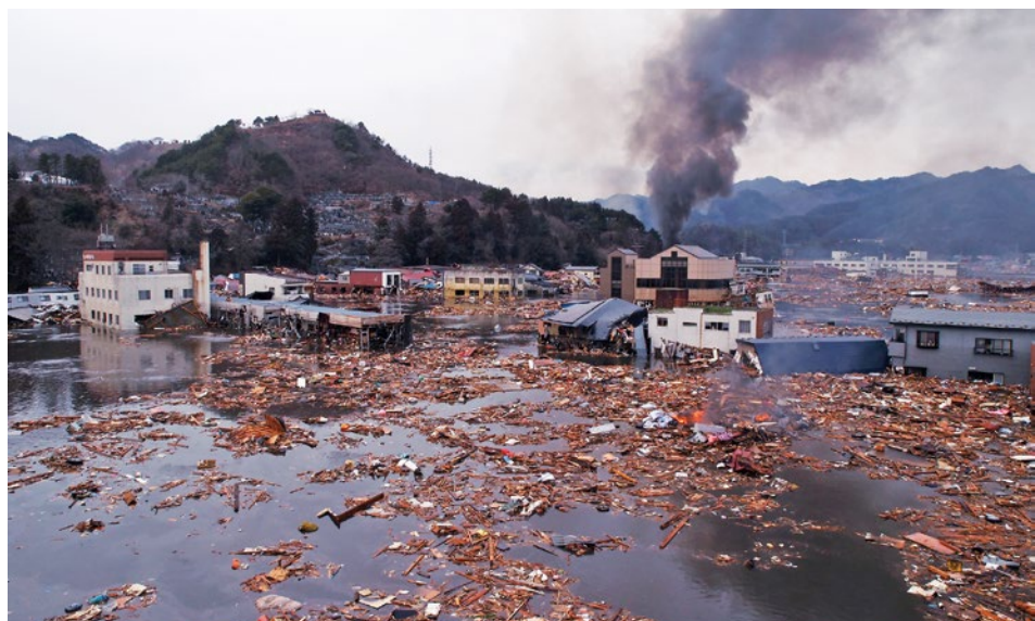
浸水した町方地区。津波の直後、町内各所で火災が発生した
