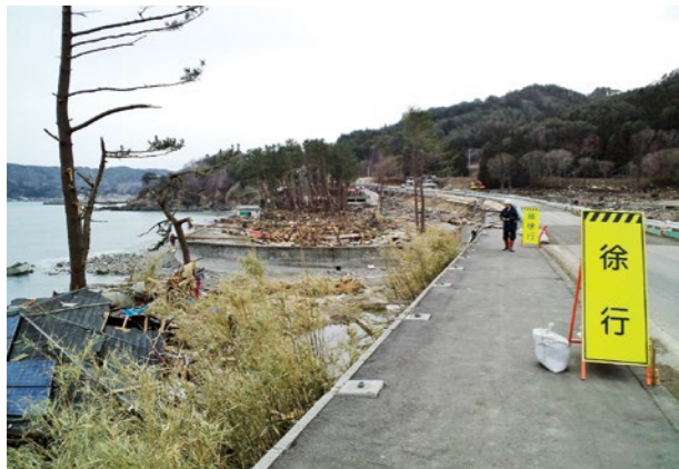
浪板川にかかる国道45号の浪板橋が津波で損壊したため、補修した(2011年3月22日撮影)。河口付近に広がっていた砂浜は消失した
