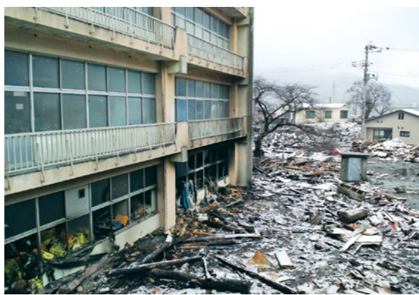
源水地区の大樋中学校は1階の天井付近まで浸水したとみられ、火災の痕跡も確認できる(2011年3月16日撮影)。当時同校にいた生徒たちは城山方面に避難して無事だった
