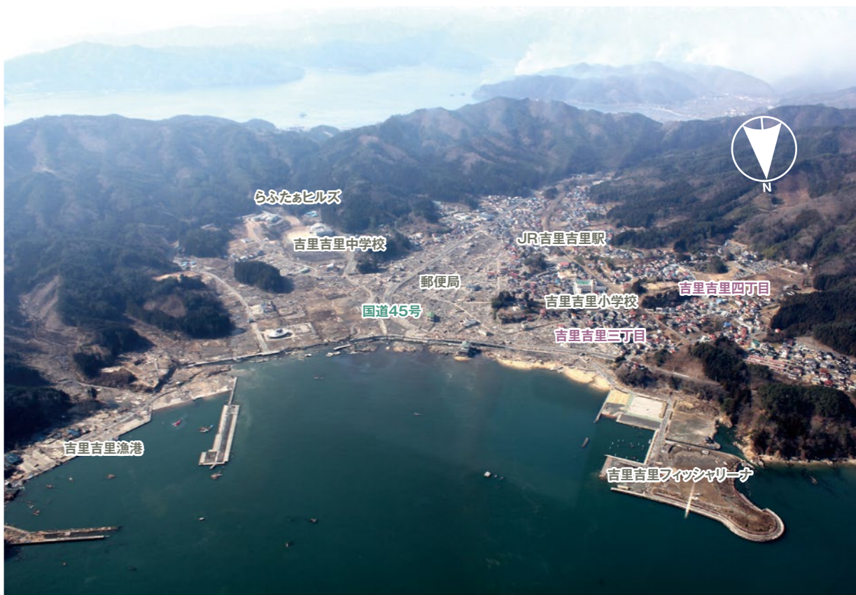
低地部やJR山田線(当時)より東側の市街地が大きな被害を受けた吉里吉里地区(2011年3月14日撮影) ※写真中の情報は震災当時。方位は目安
