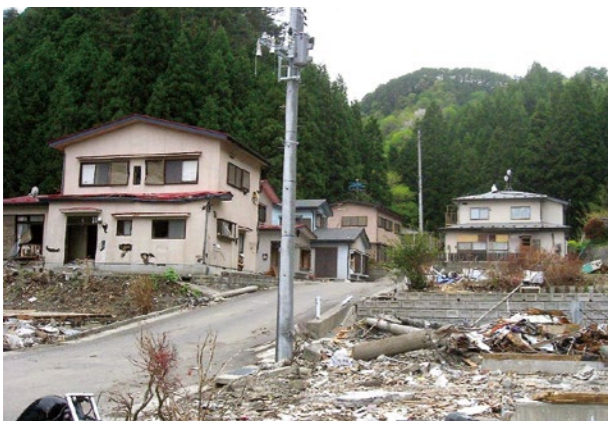
被害を受けたが、流失を免れた小枕地区の家屋
