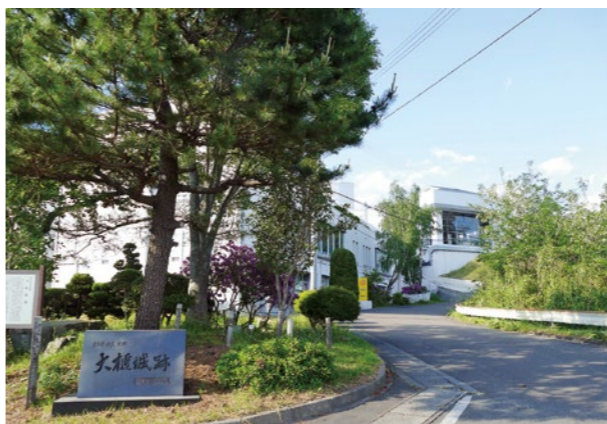
城山の中央公民館。震災当時の地域防災計画では、役場庁舎が災対本部として使用できない場合に仮設本部が置かれることになっていた
