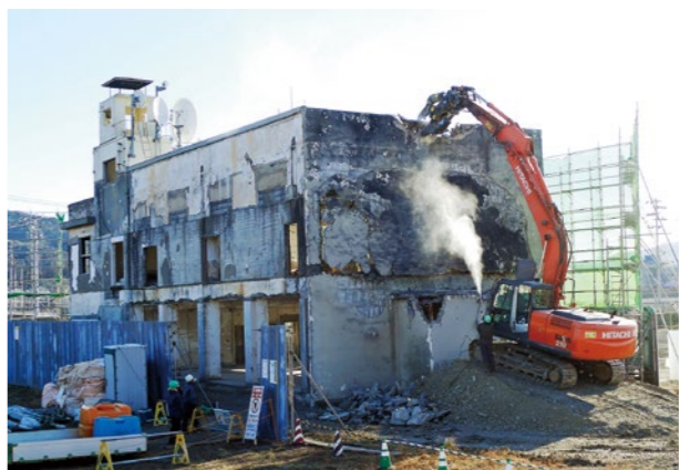
被災から8年近くを経て、解体される旧役場庁舎(2019年1月19日撮影)
