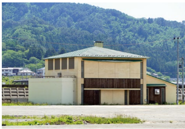
大槌川沿いに立つ大町雨水ポンプ場。四戸直紀職員はバルコニー部分に飛び乗った
