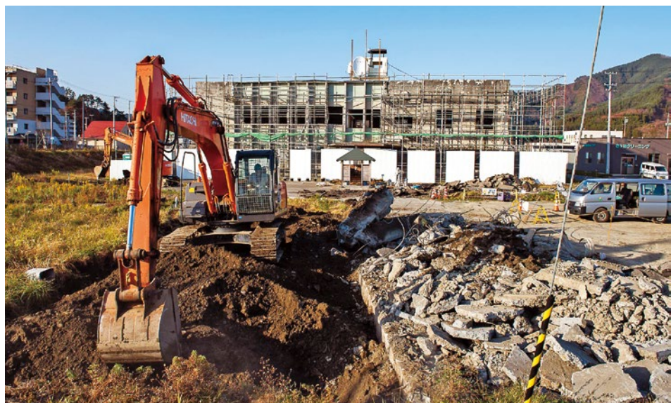
アスファルト舗装の撤去が進む旧役場庁舎前の更地（2018年12月3日撮影）
