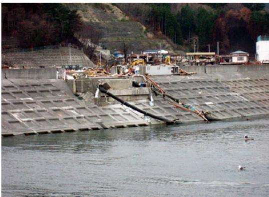
津波で破壊された安渡橋。同時に水道管も破損した
