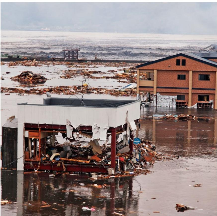
押し寄せた津波の力によって、鉄筋の建物でさえ骨組みだけになってしまった
