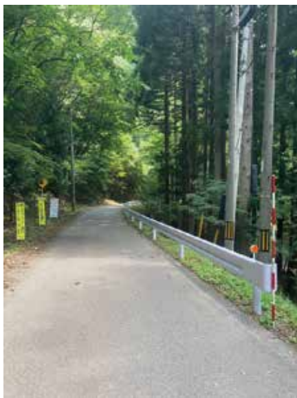
町内事業者からの提言により施工されたガードレール
