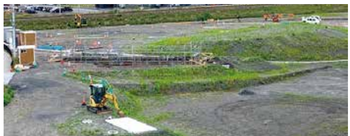
地元企業による（仮称）鎮魂の森整備工事現場
