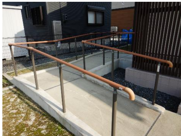
スロープ(L棟)
