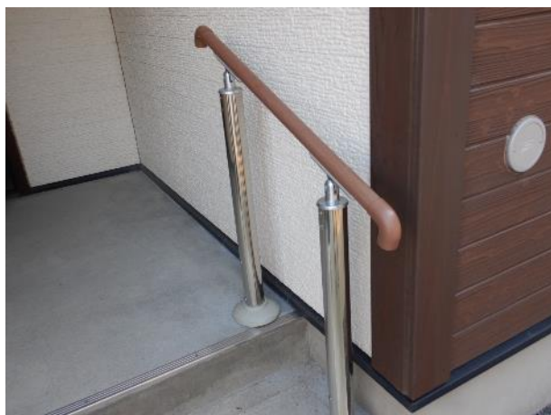
玄関ポーチの手すり
