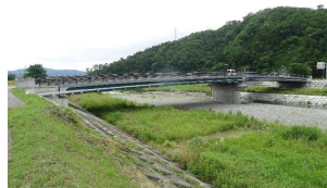
写真1 源水大橋(鋼橋:橋長91.2m)
