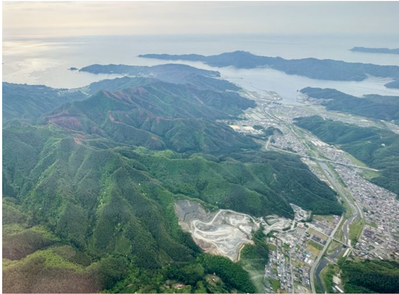
5月19日(火) 撮影 釜石大槌地区行政事務組合消防本部 提供
